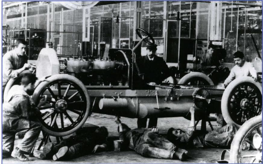
**Bild 1: Mit dem Pinsel erfolgt der Lackauftrag – teilweise unter umständlichen Über-Kopf-Arbeiten. Diese Szene um 1905 zeigt die Lackierung eines Benz-Fahrgestells**
